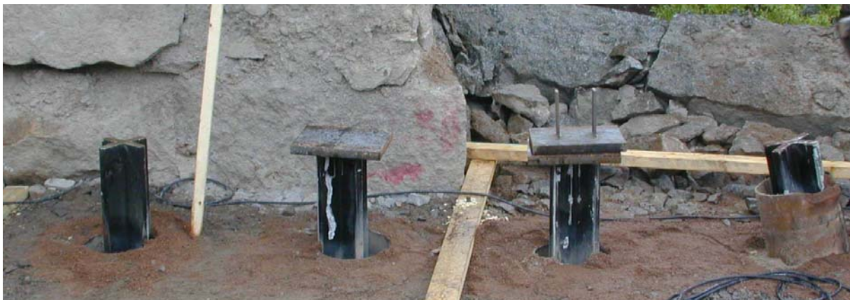
Figur 5-2: X-pålar som användes för bron över Leduån i Sverige, omgivna av lös sand.
