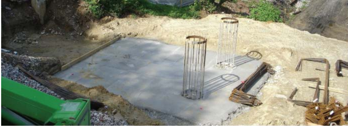
Figur 5-3: Betongpålar som användes för Entenpfuhler bridge i Tyskland (armering).
