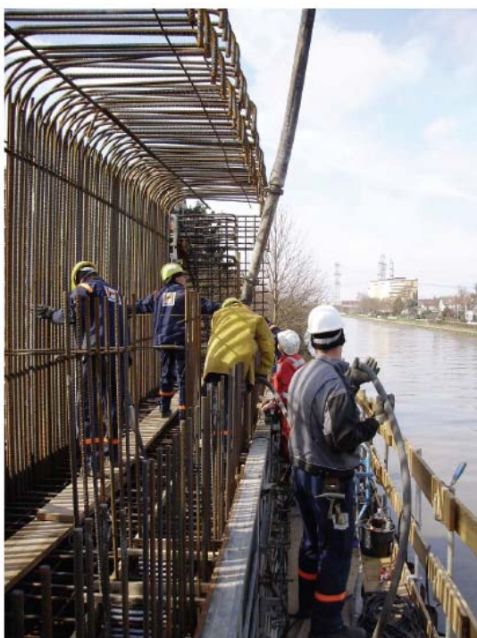
Figur 13-3: Placering av armering
