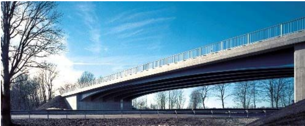
Figur 1-5: Integrerad bro, BAB A8 (SSF), grundlagd med hög inspänningsgrad
