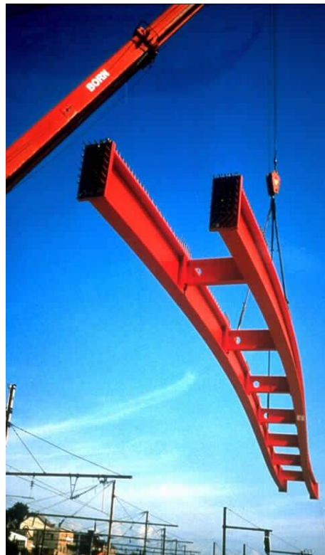
Figur 14-1: Överhöjning av stålbealkar, slutprodukt (Hechler, 2010)
