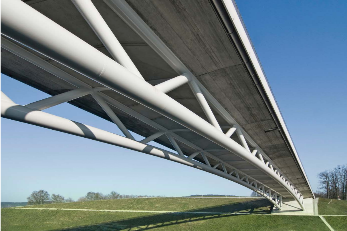
Figur 1-2: Samverkansbro med integrerade landfästen av SSF, A73 (München), Tyskland
